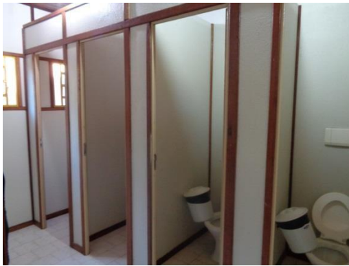
Padrão banheiro alojamento Amarelo
