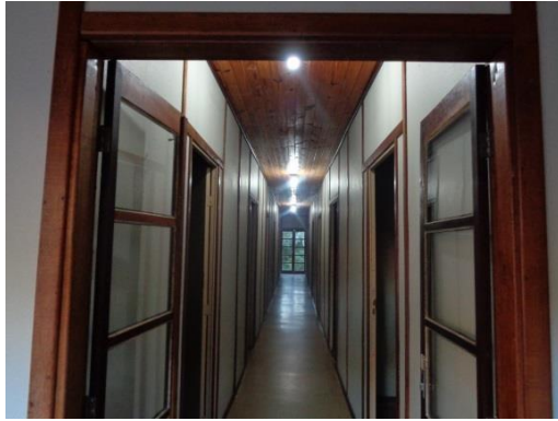
Corredor dos quartos- alojamento Amarelo
