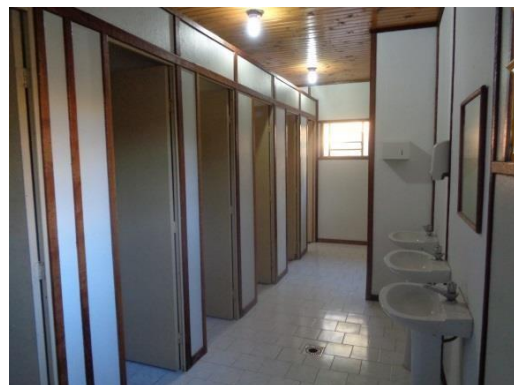
Padrão banheiro alojamento Amarelo
